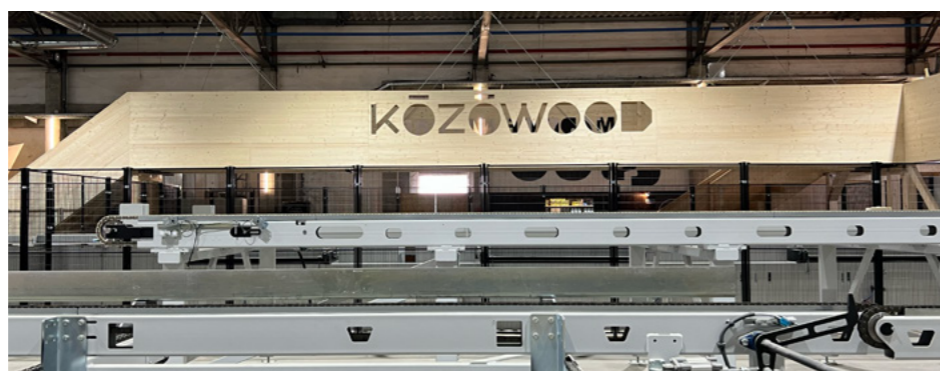
Fotos: Uso de instalación de ensamblaje, mesas de montaje y puentes multifunción en la planta de Közöwood.
