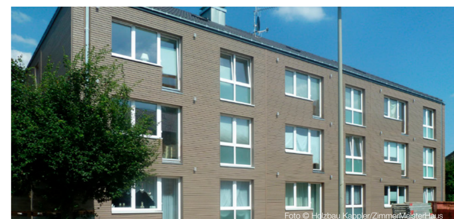
Foto © Holzbau Kappler/ZimmerMeisterHaus
