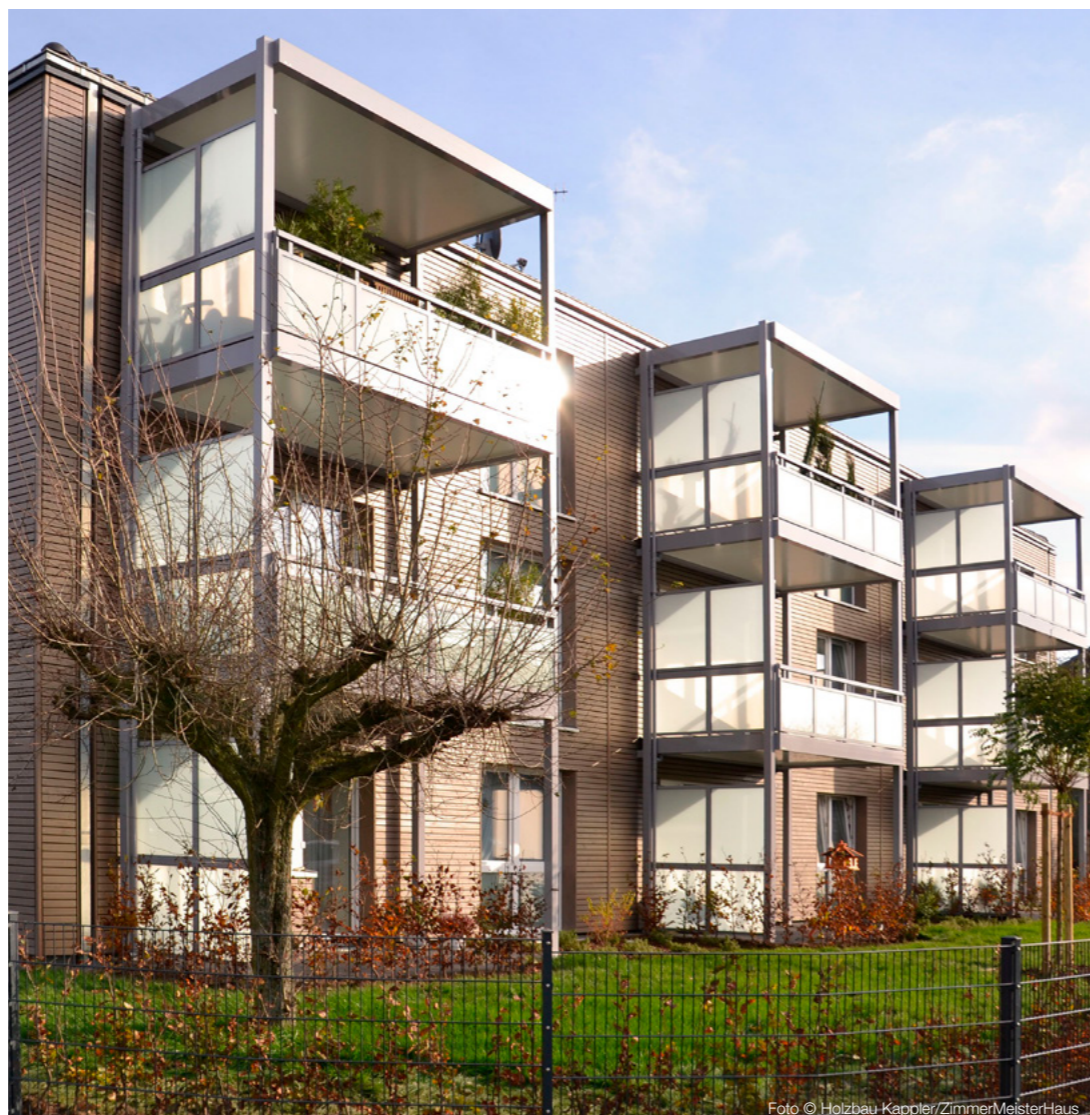
Foto © Holzbau Kappler/ZimmerMeisterHaus
