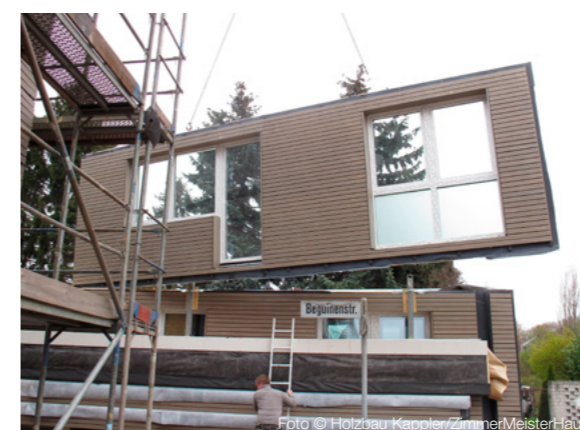
Foto © Holzbau Kappler/ZimmerMeisterHaus
